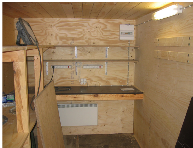
En efterisoleret container skaber gode forhold
